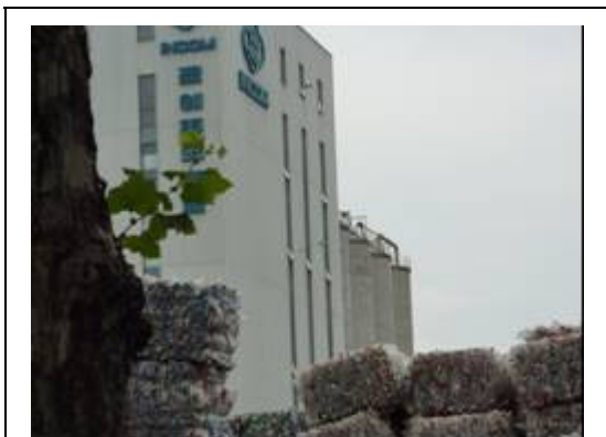
建物の奥に見える4つのサイロは、固相重合品の貯蔵タンク。
