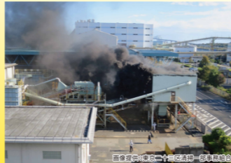
粗大ごみに混入した充電式電池 が原因の粗大ごみ破砕処理施設 での火災の状況
