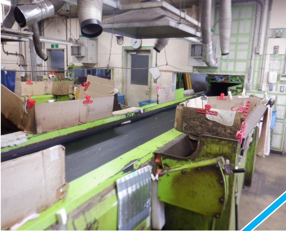
金属探知機据付前
